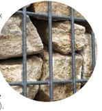
Une fois les poteaux bien scellés, positionner et lier les panneaux au sol avec les cloisons verticales (1 cloison par mètre) à l'aide des spirales ou des agrafes (une agrafe tous les 10cm).
