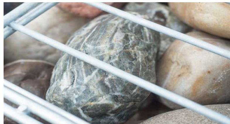
L'application la plus populaire pour les résidences de particuliers consiste en l'élaboration d'un mur de soutènement. Ces constructions n'ont besoin d'aucune fondation ou semelle particulière.
