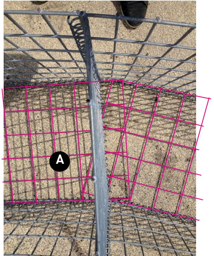
(D) Dans certains cas, il sera nécessaire de recouper verticalement une ou deux mailles des panneaux intérieurs. Cette opération s'effectue aisément à l'aide d'une simple disqueuse.
