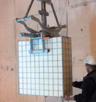
Pince de levage permettant une mise en place aisée des Gabions-Massif®
