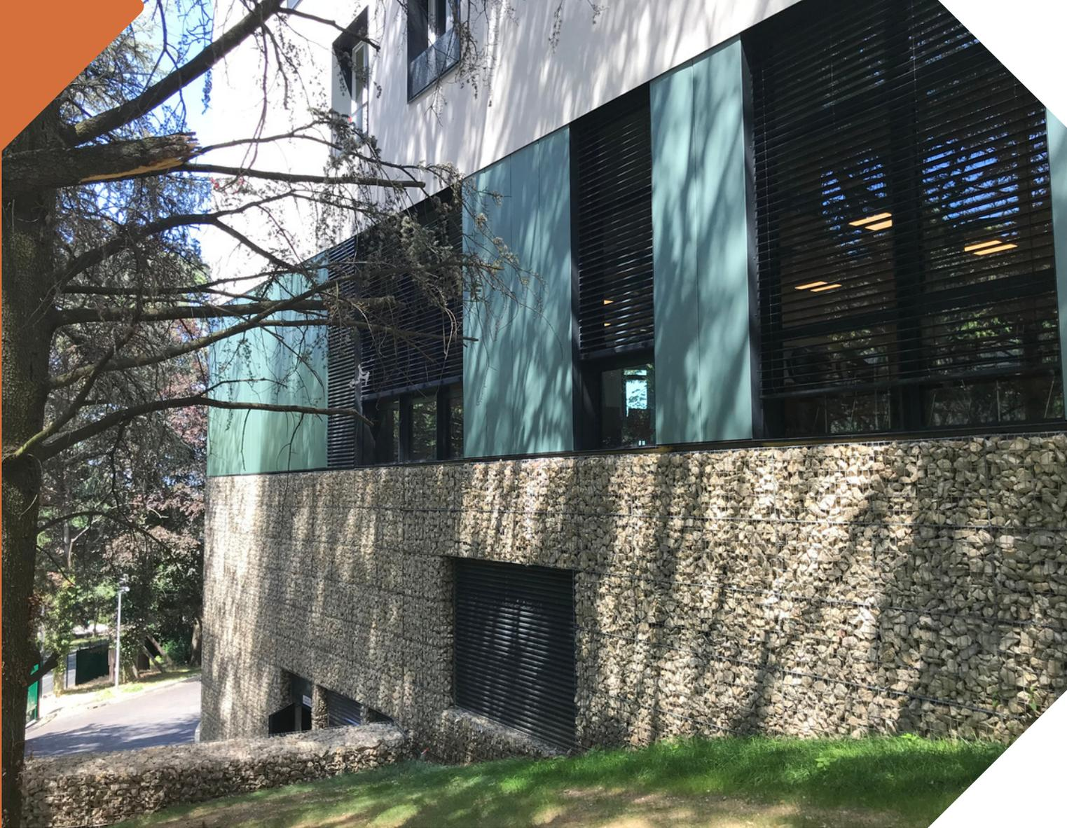
Cette technique d'habillage de façade en gabion est de plus en plus tendance. Elle permet de réaliser des parements minces, de 15 à 50 cm (30 cm le plus courant) avec des finitions exceptionnelles.
